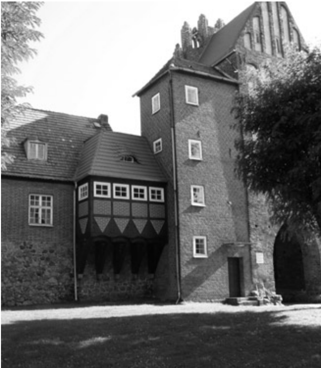
Ryc. 6. Brama Młyńska z dobudowaną klatką schodową, stan obecny
