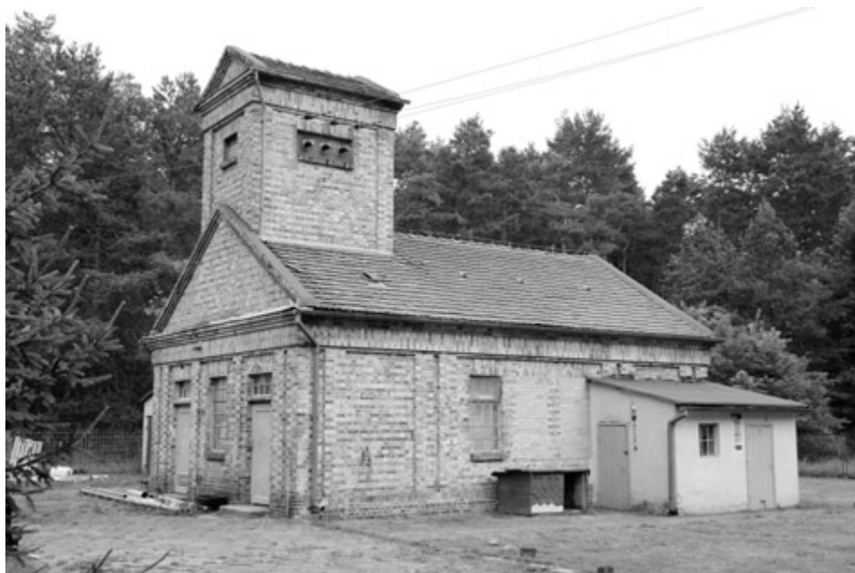
Ryc. 4. Budynek stacji pomp od południowego zachodu na terenie ujęcia wody w Sławnie w 2016 r., fot. Miron Urbaniak
