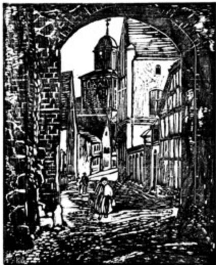
Ryc. 2. Widok zza furty przy Baszcie Więziennej w stronę kościoła Mariackiego, MOG/V/3/2
